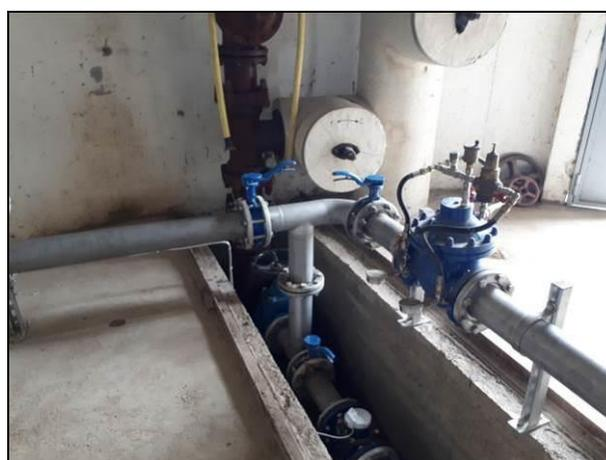
**Photo 6 : Refoulement du captage et caniveau technique**
